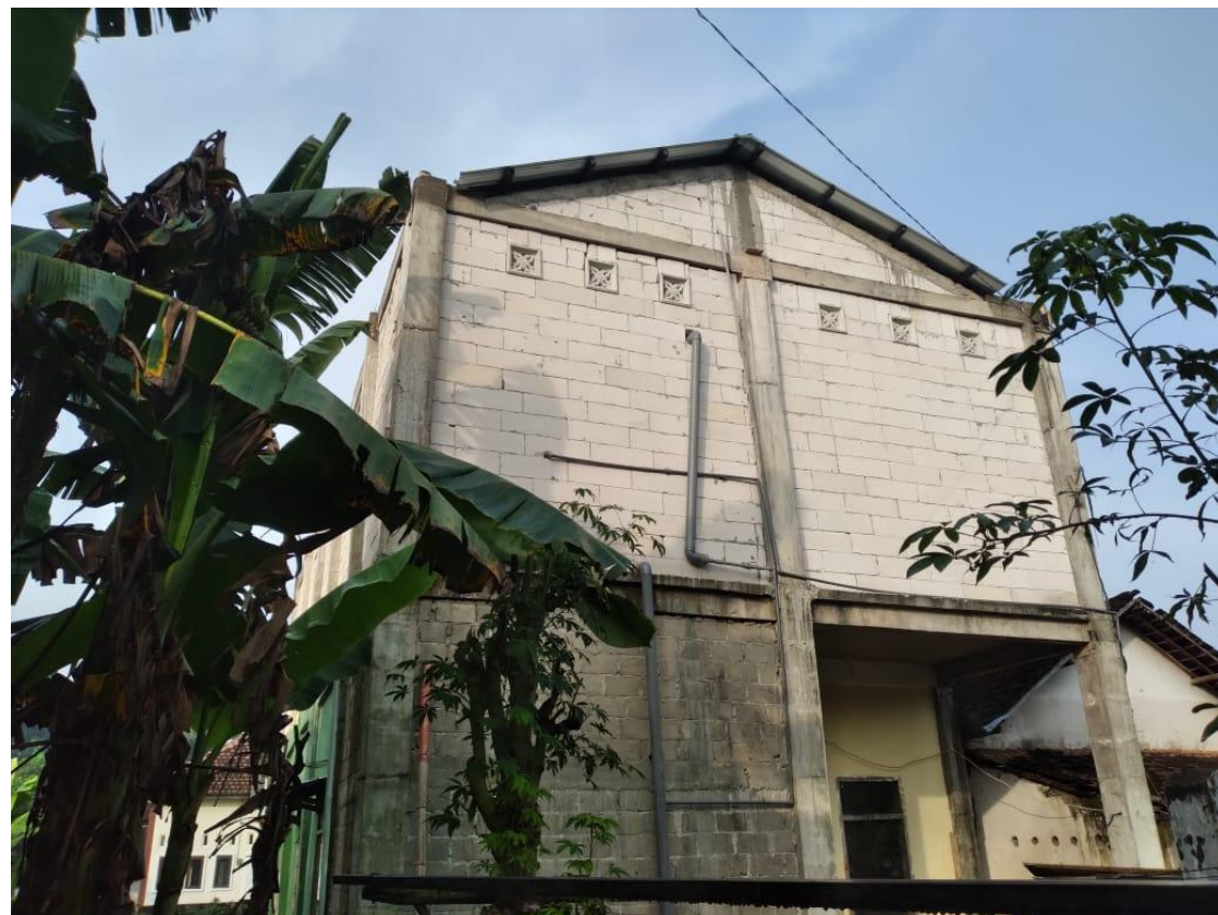
FOTO TAMPAK BELAKANG
