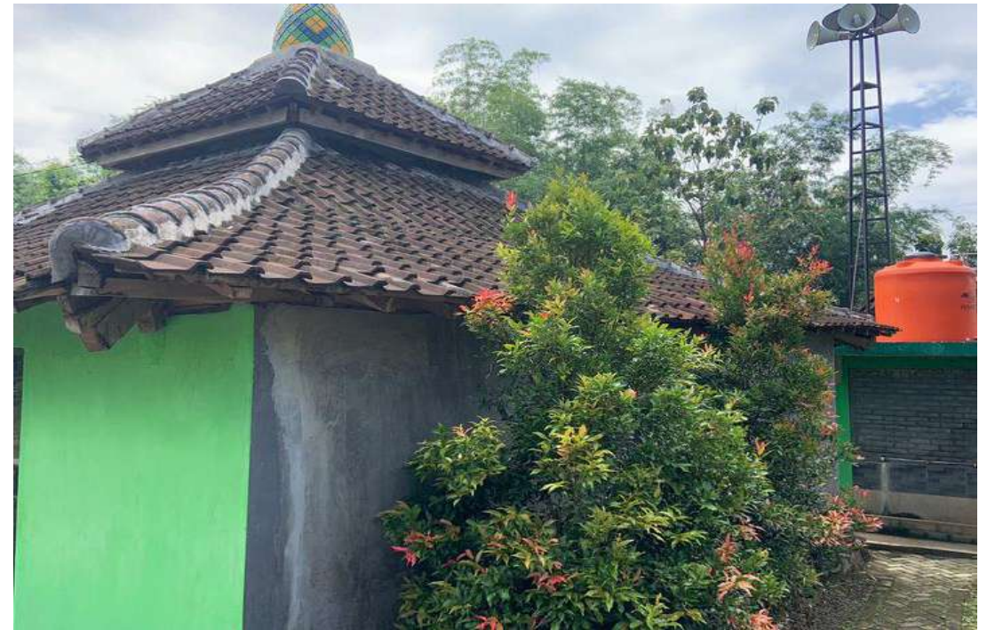
FOTO TAMPAK BELAKANG
