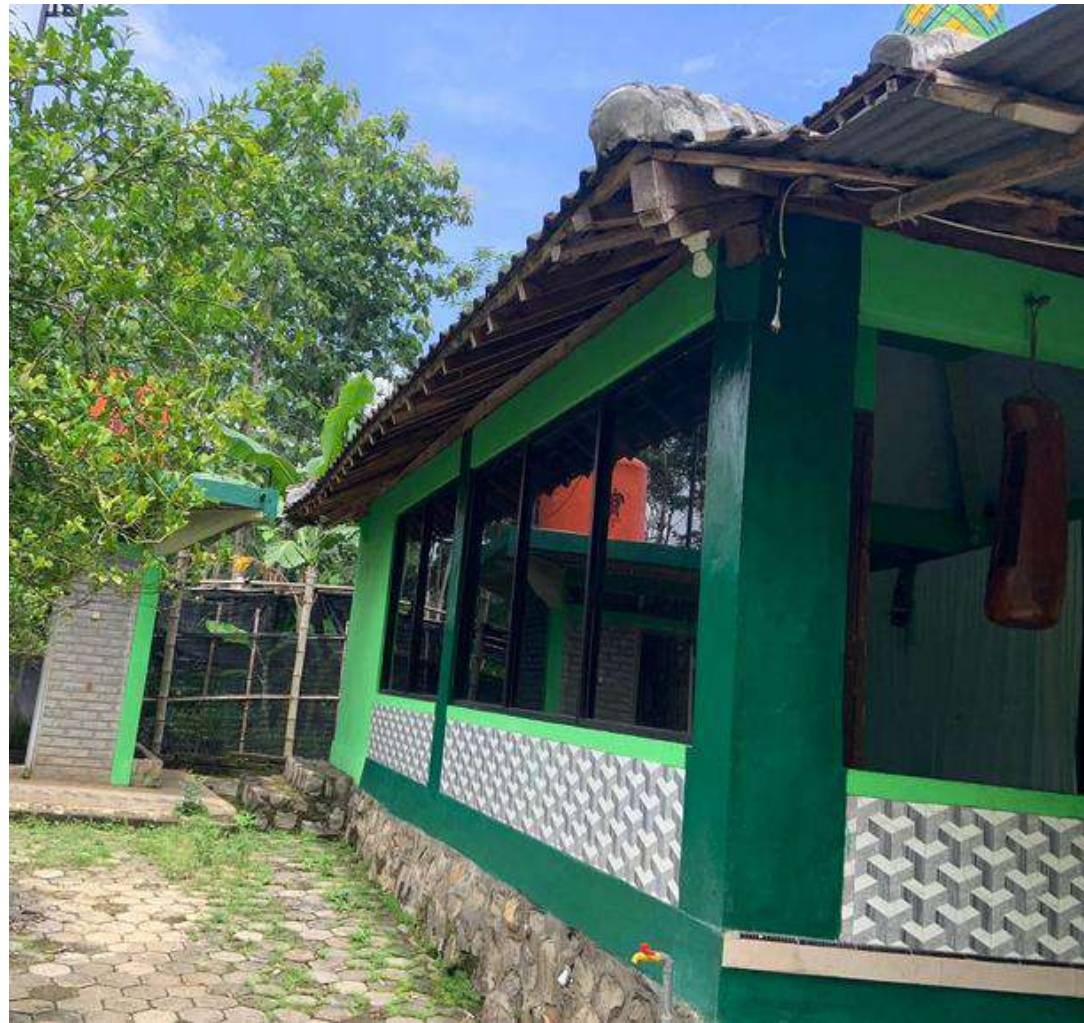
FOTO TAMPAK SAMPING KANAN
