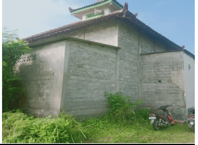
FOTO TAMPAK BELAKANG
